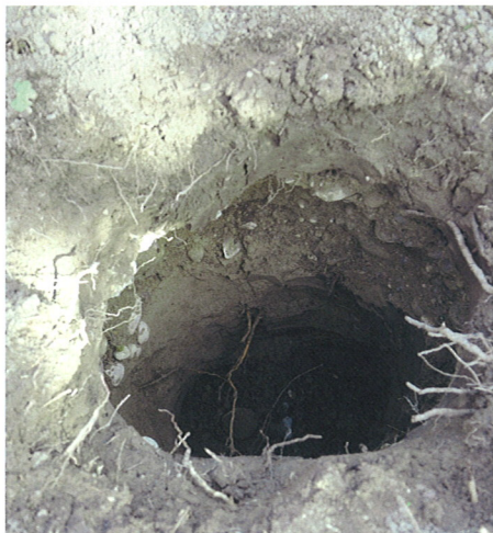
... und innert Minuten ein punktgenaues Loch saugen, statt baggern.
