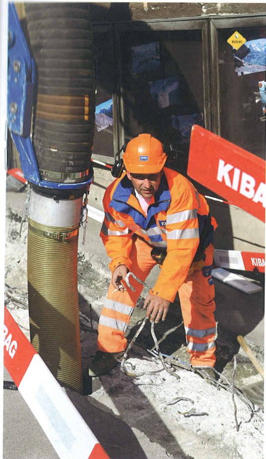
Edi Flury mit dem Saugbagger im Einsatz.
