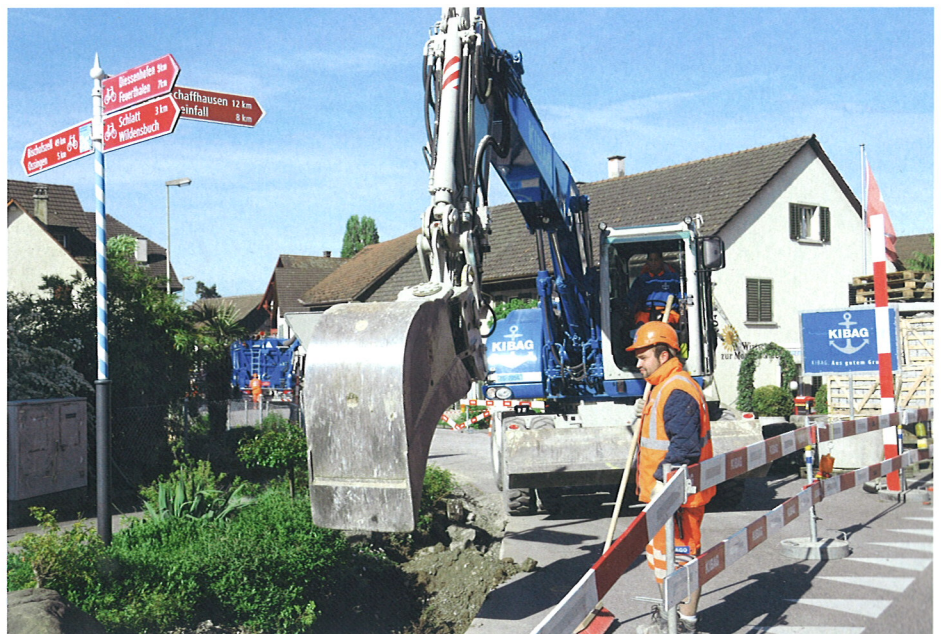
Der Saugbagger ergänzt die Arbeiten auf Baustellen, wie hier in Trüllikon.
